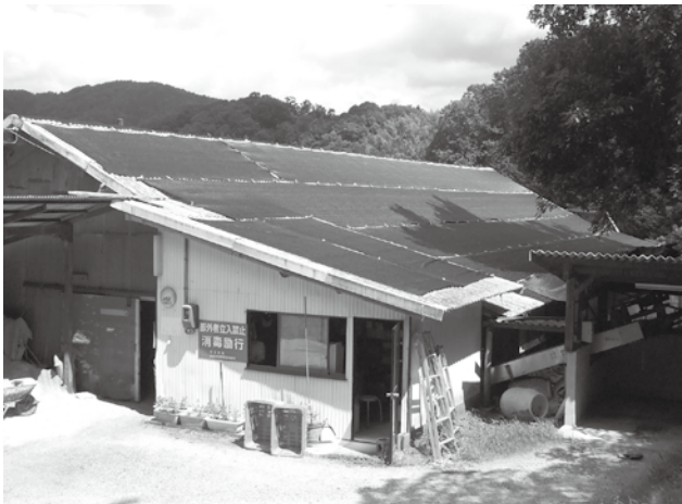
(寒冷紗におおわれた牛舎屋根) (広島市・渡辺牧場)
