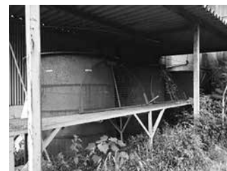
③糖蜜タンク 1基
