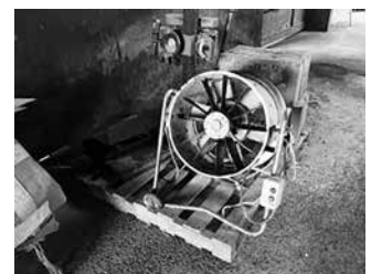
⑫送風機(1台売却) 1台
