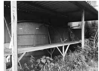
③糖蜜タンク 1基
