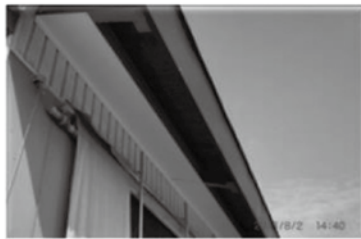
写真1 自然換気牛舎の軒開口部
