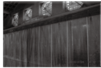
写真3 トンネル換気牛舎
