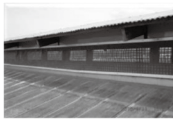
写真2 自然換気牛舎の棟開口部
