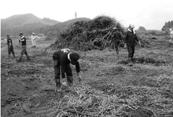
(手作業で流木等を掘り起す撤去作業。中央は集められた流木の山)
