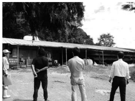
屋根の塗布部分と未実施分を確認する参加者ら
